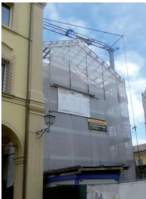
delle murature di imposta. La situazione una volta raggiunta la quota di lavoro ipotizzata, ha mostrato una serie di problematiche legate allo stato di conservazione delle murature non prevedibili al momento del progetto, vista anche la situazione di estrema pericolosità dell'edificio.
