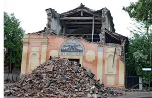
il campanile sia completamente crollato, il timpano totalmente distrutto e l'abside mostri vistose crepe diagonali; inoltre, le volte interne e parte della copertura sono quasi completamente implose all'interno della navata della chiesa.
