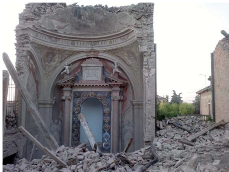
La situazione che oggi si rileva è estremamente complessa, infatti, la navata centrale è completamente occupata dalle macerie generate dal crollo di tutte le strutture di copertura con uno strato complessivo di circa cinque metri di materiale accumulato all'interno della stessa. Tutte le cappelle laterali risultano crollate
